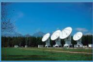
6台の望遠鏡をつなぎ、最大で直径約600mの電波望遠鏡に相当する観測が可能。主に天体の細かな観測に威力を発揮してきました。現在は運用を終了し、培った技術が南米チリにある望遠鏡に受け継がれています。
